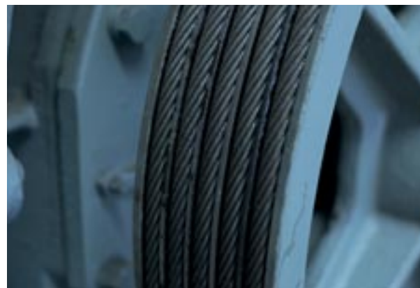
Câbles de traction, ascenseurs, monte-charges, sas, écluses
